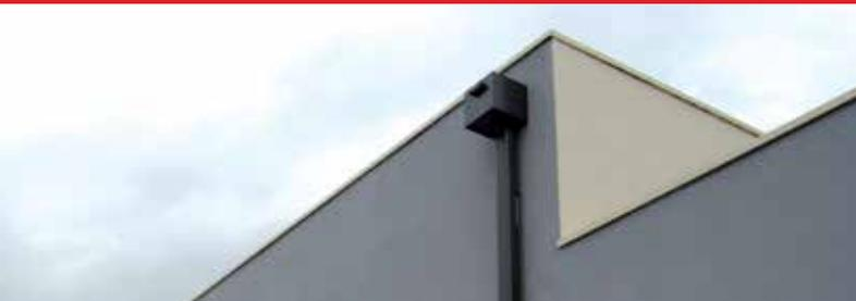
Les boîtes à eau **DAL'ALU** sont la solution efficace et esthétique pour recueillir les eaux pluviales en provenance de toitures terrasses. Pour répondre à tous les types d'architecture, **DAL'ALU** propose des réalisations standard ou sur-mesure.
